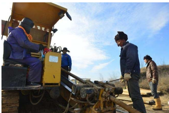
图1 微型定向钻进工艺
