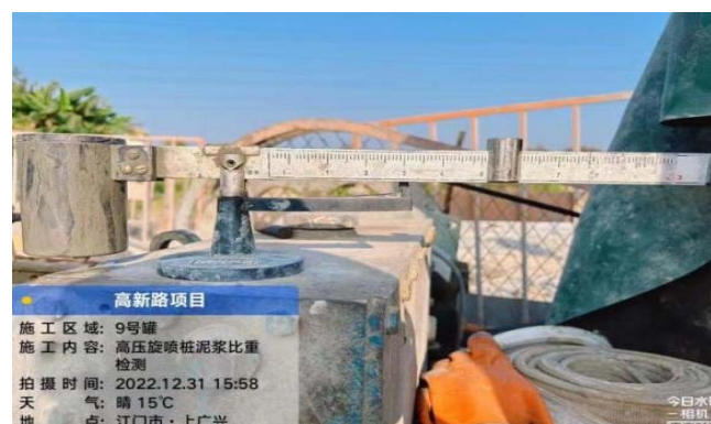
泥浆比重检测
