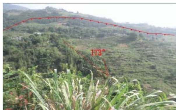
图3 滑坡实地照片
