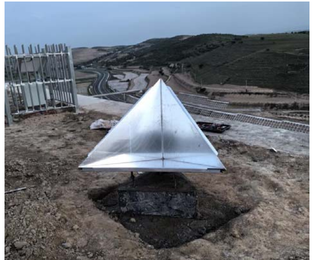
图2 人工角反射器现场安装
